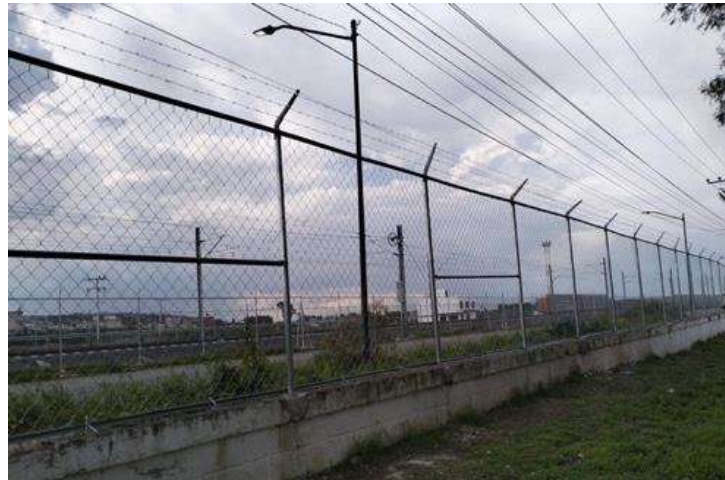
Reparación de Maya Ciclónica Unidad Habitacional Portal San Pablo I
