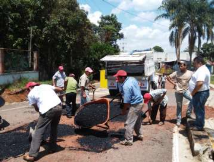
Bacheo del camino principal de la localidad de Capulapa, Huatusco.
