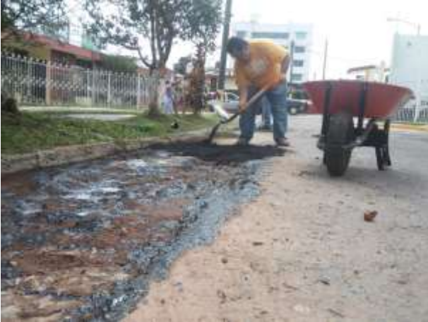
Bacheo de la calle de los maestros en Huatusco.
