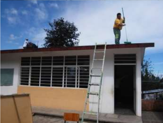
Pintando tu escuela, impermeabilizada y entrega de balones para la escuela primaria Francisco Morosini de San José Chapa, Huatusco.
