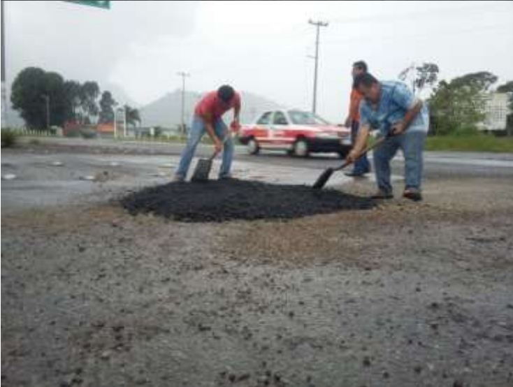
Bacheo de prolongación de calle 12 y boulevard de la ciudad de Huatusco.
