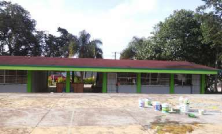
Pintando tu escuela y construcción de terraplén para canchas de futbol en la escuela secundaria técnica #144, Huatusco.
