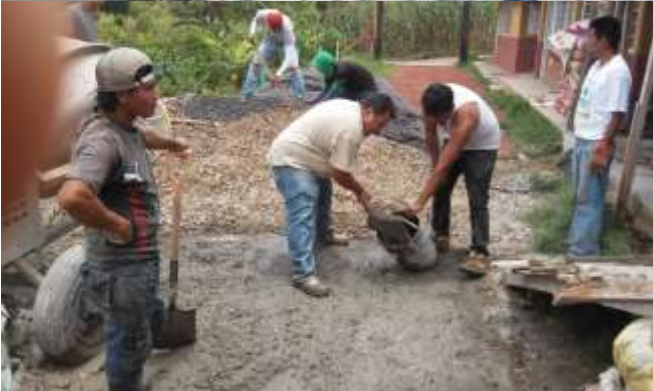
Colado de losa para el Tebaev que se ubica en la colonia Francisco I. Madero que pertenece a la localidad de Tenejapa, Huatusco.
