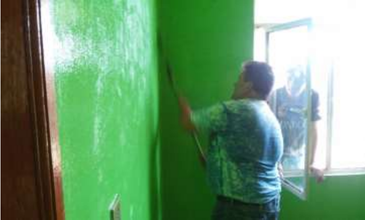
Pintando la casa de salud de la localidad de Capulapa, Huatusco.
