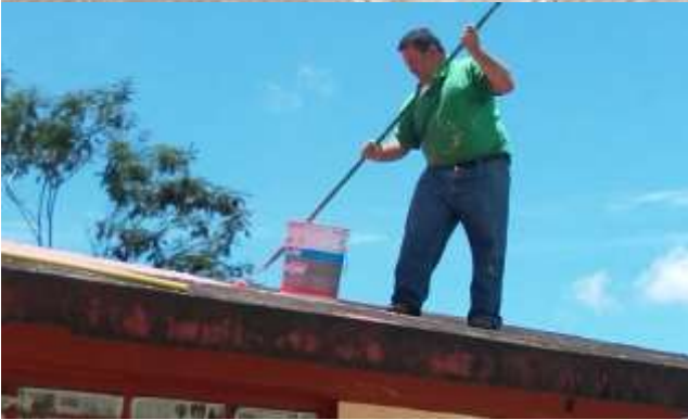
Pintando tu escuela e impermeabilizado del TEBAEV de Sabanas, Huasco.
