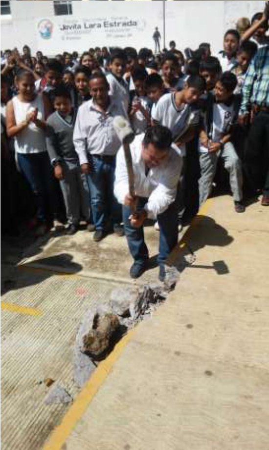
Inicio de obra de demolición y construcción de edificio para la secundaria Jovita Lara Estrada de Huatusco.
