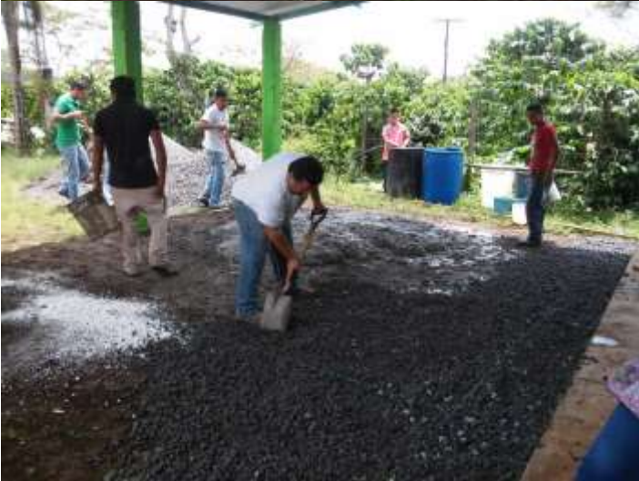
Construcción de piso en casa de salud de Capulapa, Huatusco.
