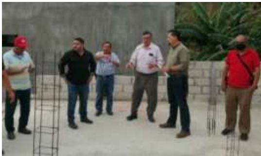
Apoyo para material de construcción, 22 de mayo de 2022
