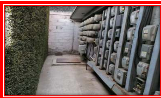
Trabajos de la CFE.
