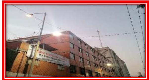
Instalación de la luminaria
