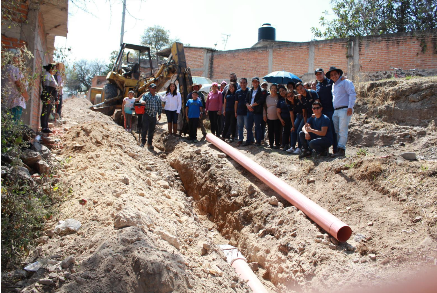
Proyecto de rehabilitación del drenaje en la Comunidad de San Lorenzo.
