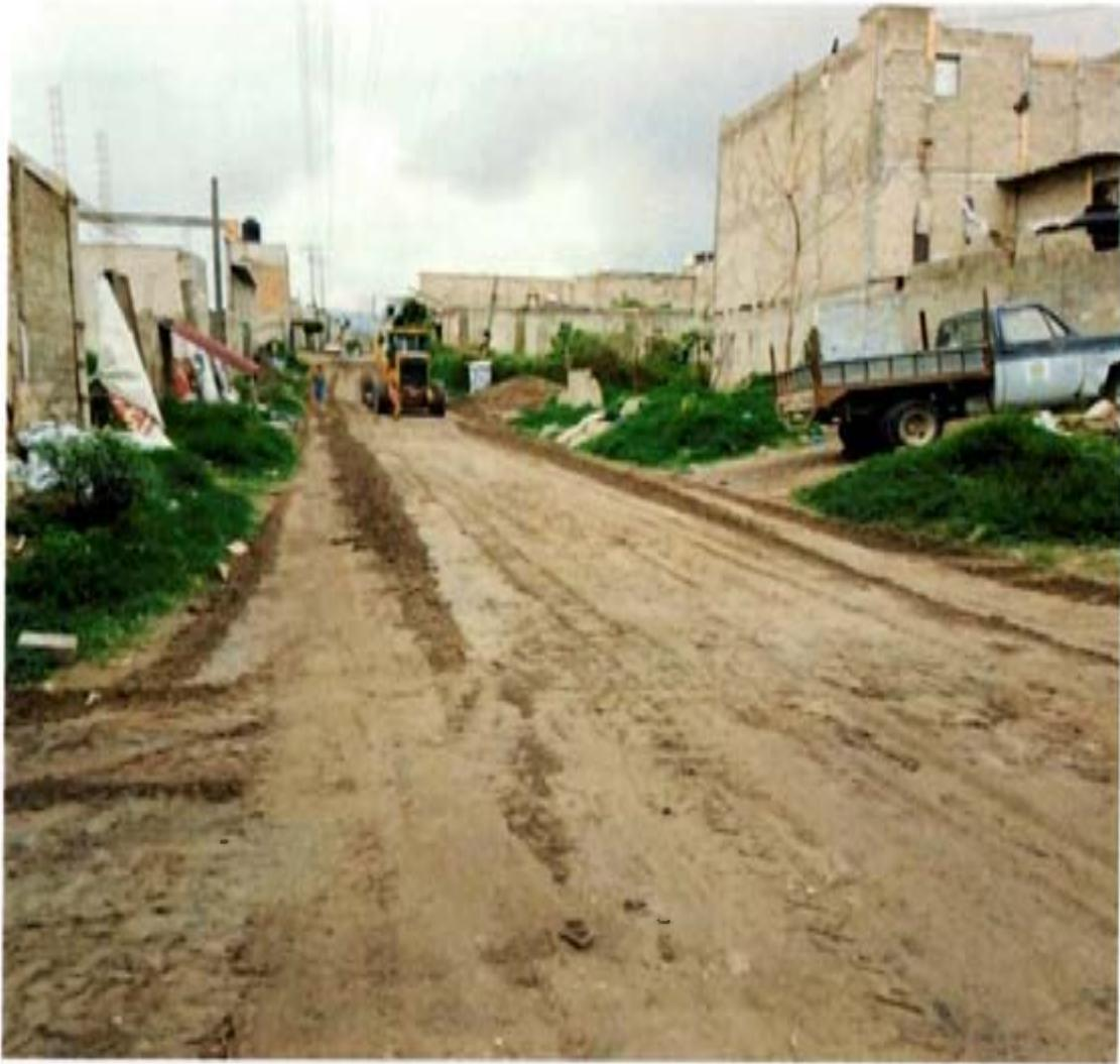
En el mes de julio y con apoyo de la Dirección de Obras Públicas e infraestructura del Municipio de Zapopan dieron inicio los trabajos en la calle Violeta de la Colonia Floresta del Distrito 6, la cual contará con pavimentación de concreto hidráulico, sustitución de redes hidrosanitarias, banquetas incluyentes, crucesos seguros y arbolado.
