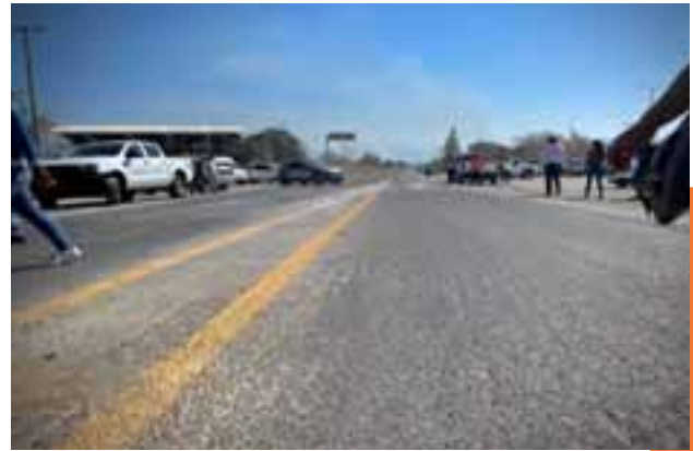
Glorieta al ingreso del municipio de Zapotiltic.
