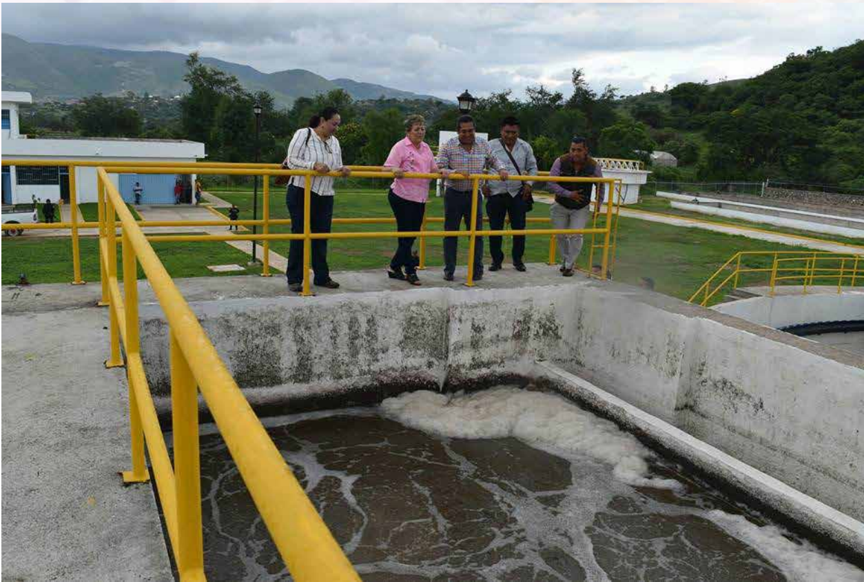
La Planta Tratadora de Agua en el municipio de Chilapa de Álvarez.
