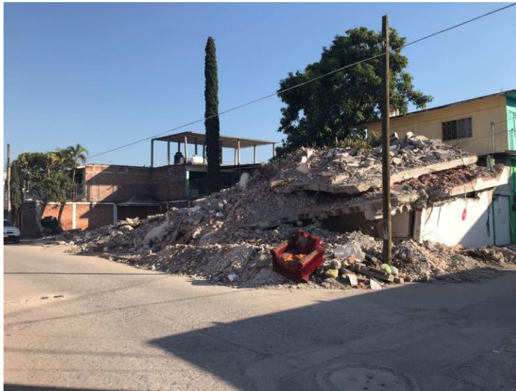
Daños ocasionados a la infraestructura por el sismo en Jojutla de Morelos.
