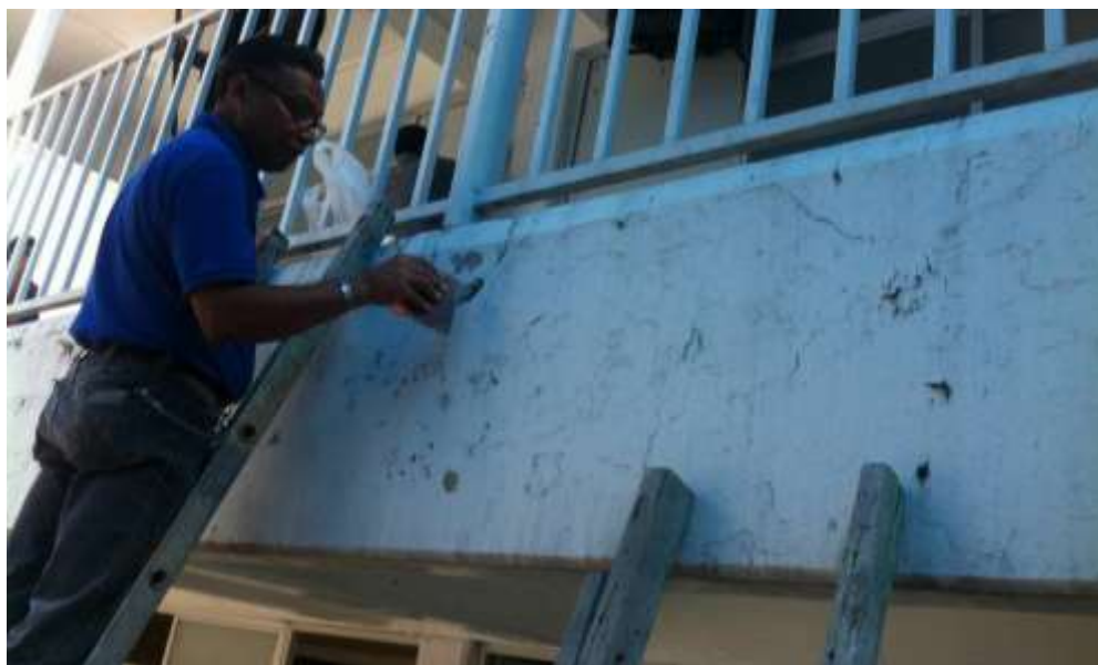
Tlalnepantla, Edomex. Trabajos de rehabilitación en escuelas públicas.
