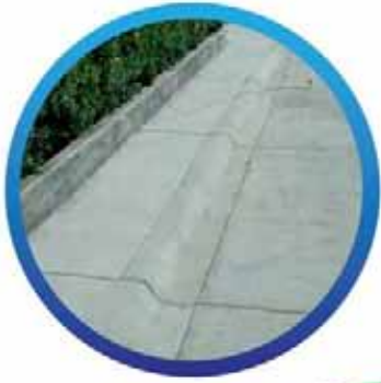
Banquetas y Guarniciones
