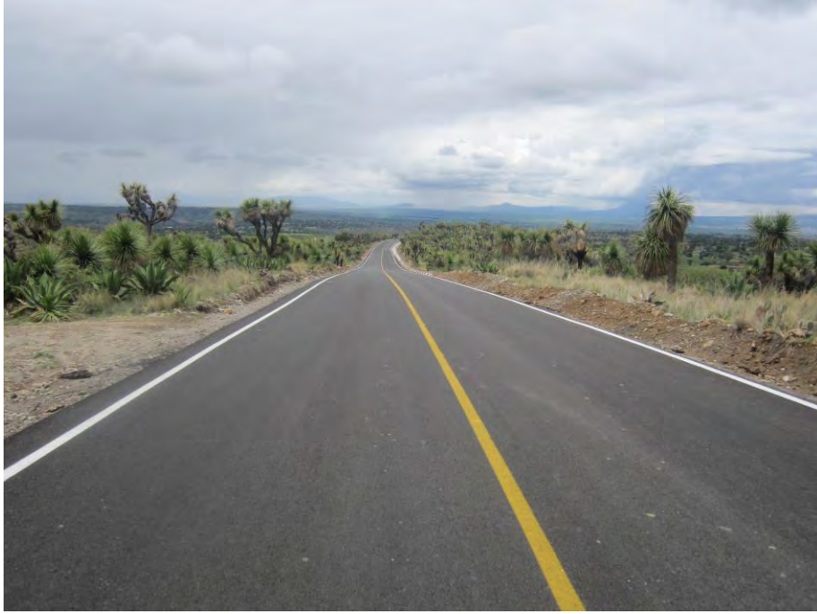
Carretera Mesa Redonda-La Garita, municipio de Alzayanca.
