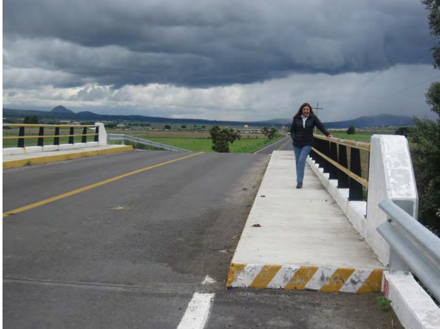
Puente: El Valle, ubicado en el municipio de Huamantla, sobre carretera Benito Juárez- San José Xicotécatl.
