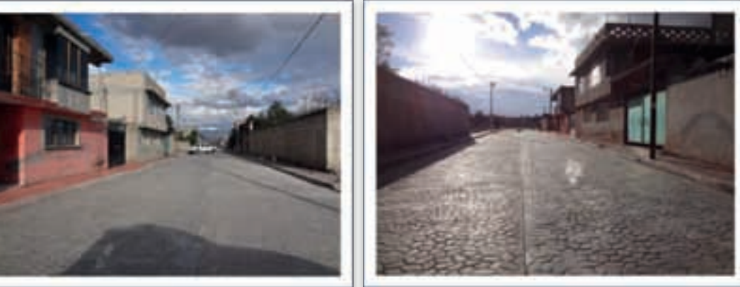
PAVIMENTACIÓN DE LA CALLE LÁZARO CÁRDENAS, COLONIA SAN ISIDRO, RAYÓN.
