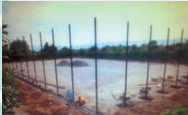
CONSTRUCCIÓN DE CANCHA DE FUTBOL RÁPIDO EN LA CABECERA MUNICIPAL.
