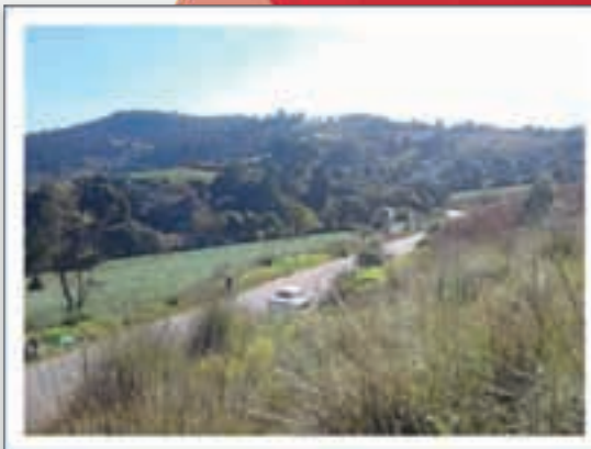
MODERNIZACIÓN DEL LIBRAMIENTO "CAMINO VIEJO A TENANCINGO" EN SAN BARTOLOMÉ ATLATLAHUCA.
