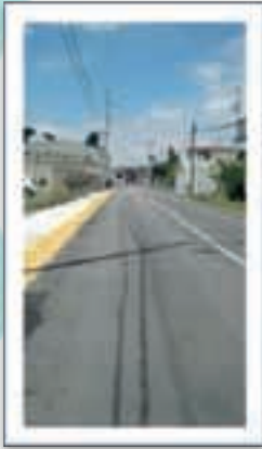
PAVIMENTACIÓN CALLE ÁLVARO OBREGÓN Y CALLE DE LA LLAMA EN EL PARQUE INDUSTRIAL. CABECERA MUNICIPAL.
