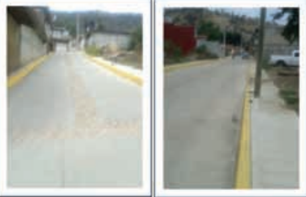
PAVIMENTACIÓN EN PROLONGACIÓN MORELOS, IXTAPAN DE LA SAL.
