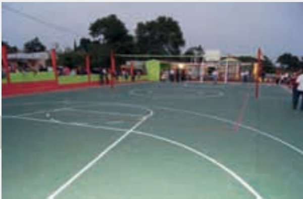
CONSTRUCCIÓN DE LA CANCHA MULTIFUNCIONAL EN LA CABECERA MUNICIPAL.
