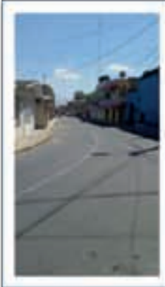
REHABILITACIÓN DEL ACCESO A LA LOCALIDAD DE SANTIAGUITO COAXUTENCO.
