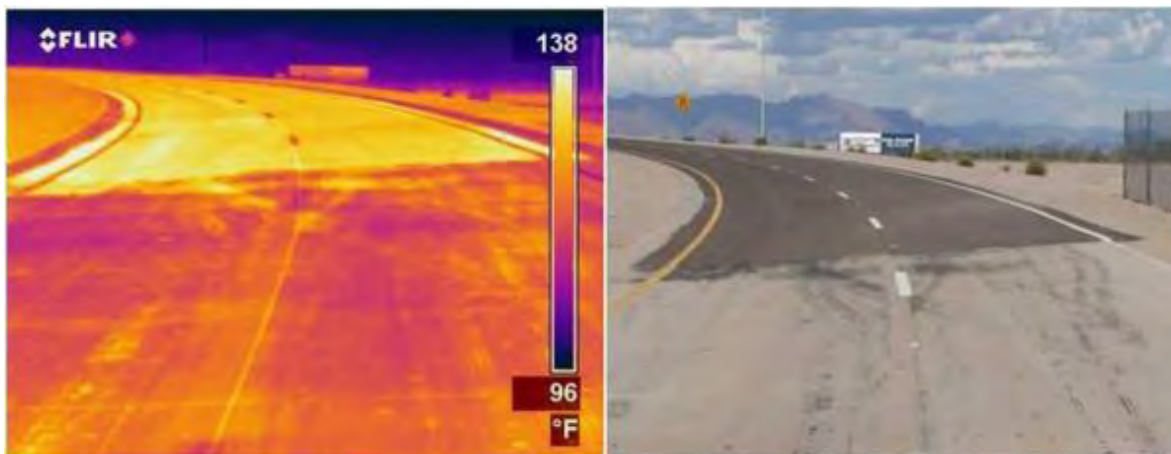
Los pavimentos oscuros expuestos a la luz del sol se calientan más que los claros, contribuyendo más al fenómeno de isla de calor. Fuente de la imagen: Larry Scofield, APCA , en la página del LBL Heat Island Group.
