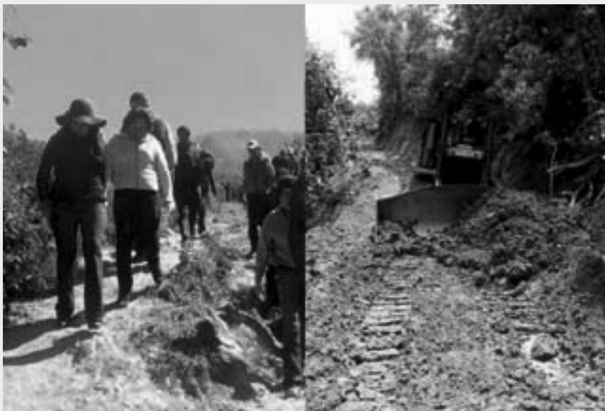
Apertura de brecha Juntas del Río, San Bartolo Tutotepec
