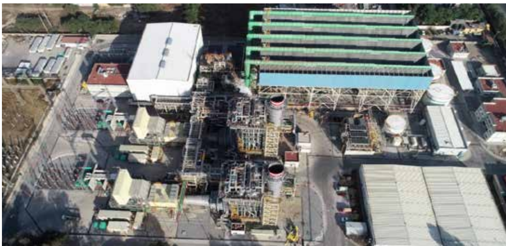
Fotografía: panorámica de la CCC Valle de México II
