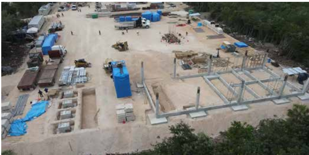
Fotografía: proceso de construcción de la Subestación de Maniobras 3
