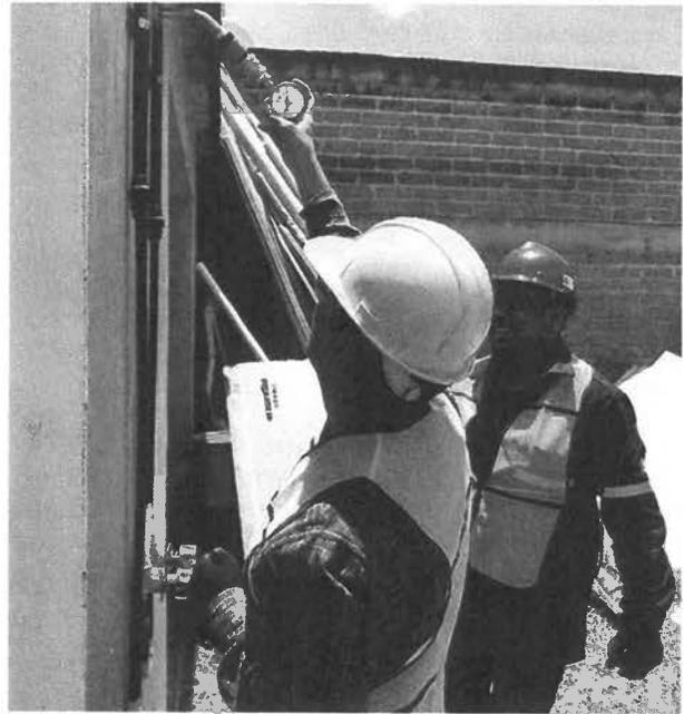
**Fotografía 24.** Registro de presión en la tubería de distribución de gas, previo a la instalación de un calentador. Comisión Nacional para el Uso Eficiente de la Energía.
