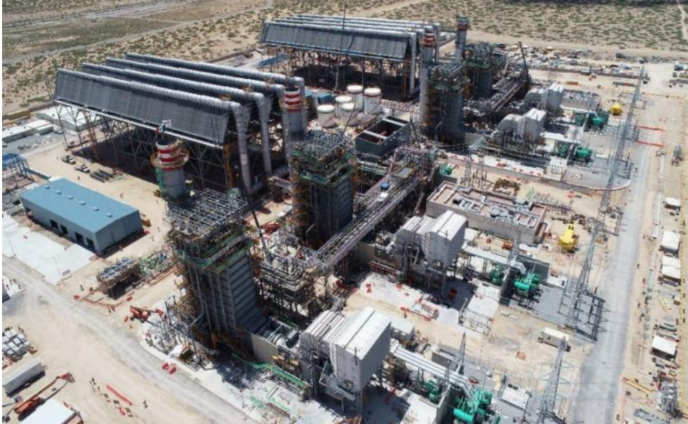
Fotografía: Panorámica del Proyecto CC Norte III
