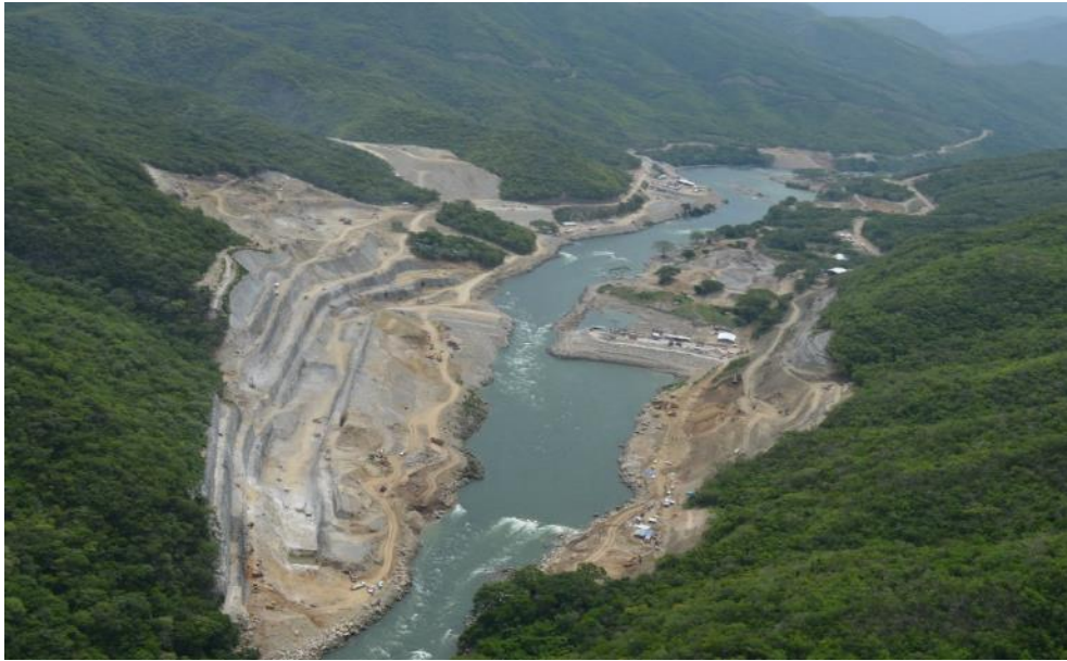
Fotografía: Avance de obra civil en el sitio del PH Chicoasén II, excavación en canal de desvío y ataguía aguas arriba.
