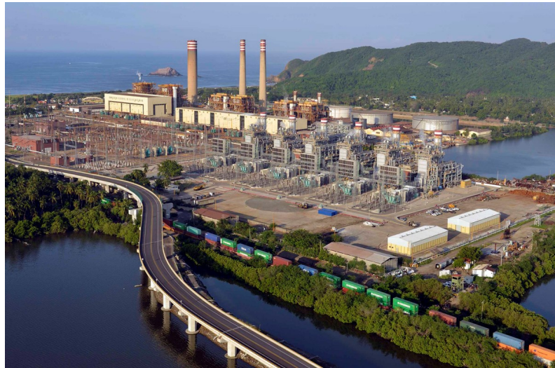
Imagen 1: Central Termoeléctrica Manuel Álvarez Moreno (Manzanillo)
