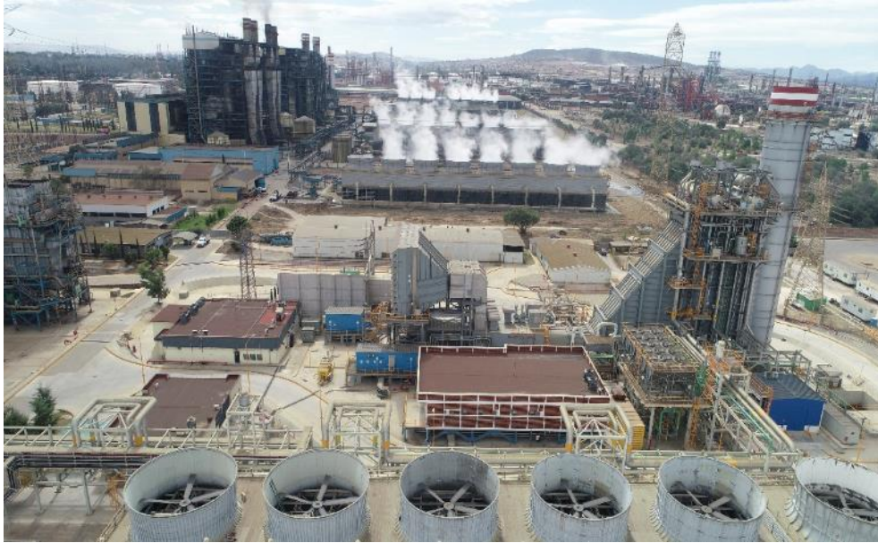
Fotografía: Panorámica del Proyecto RM CCC Tula Módulo 1
