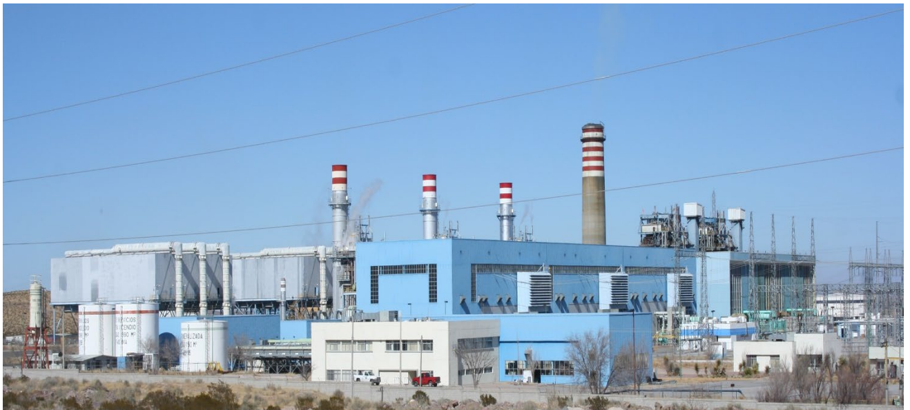
Imagen 5: Central Termoeléctrica Samalayuca
