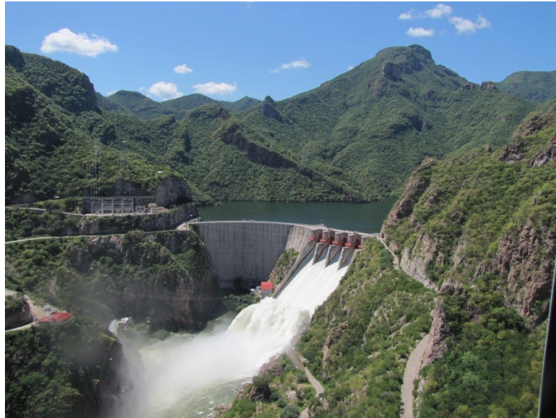
Imagen 5: Central Hidroeléctrica Pdte. Plutarco Elías Calles "El Novillo"
