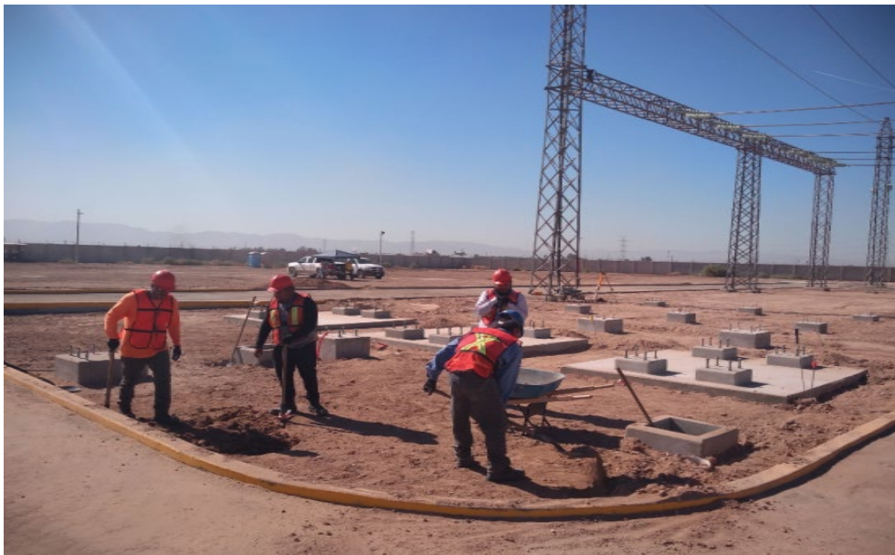
Fotografía: SE González Ortega MVAR
