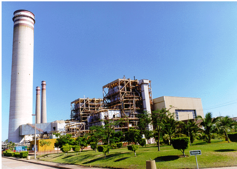
Imagen 3: Central Termoeléctrica Manzanillo II
