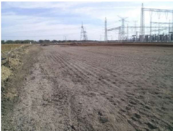
S.E. Champayan Ampl. / 304 LT 1805 Línea de Transmisión Huasteca - Monterrey
