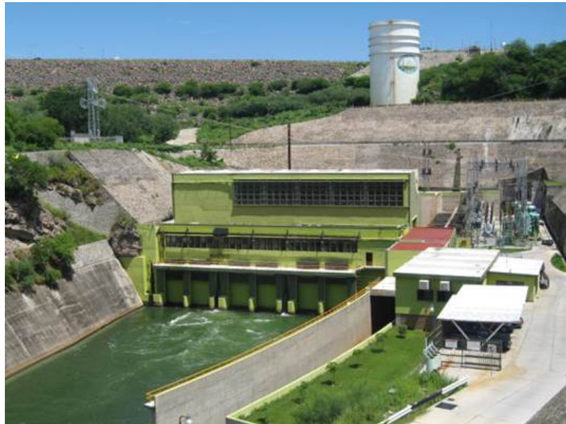
Imagen 4: Central Hidroeléctrica 27 de septiembre (El Fuerte)
