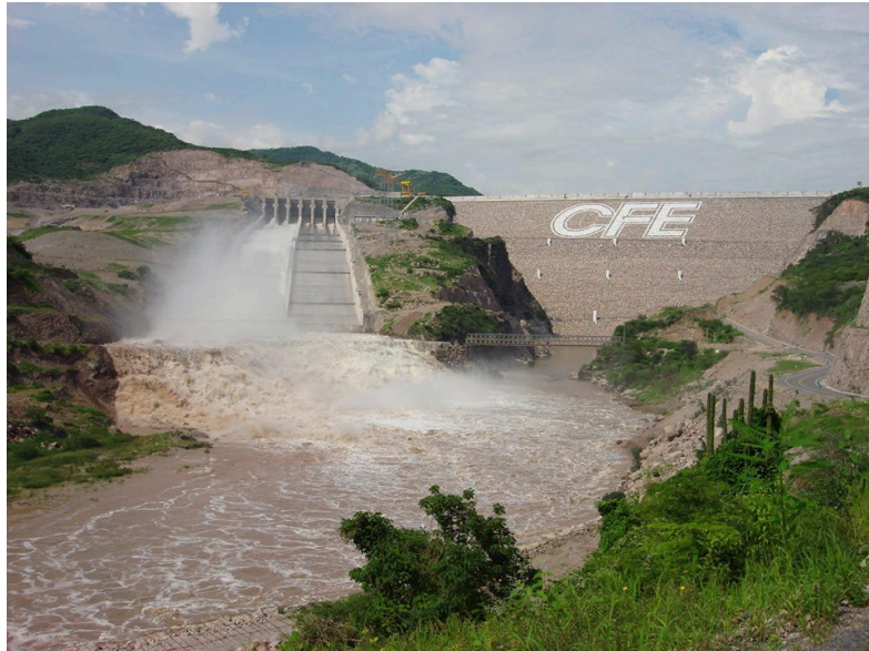
Imagen 5 Central Hidroeléctrica Leonardo Rodríguez Alcaine (El Cajón)
