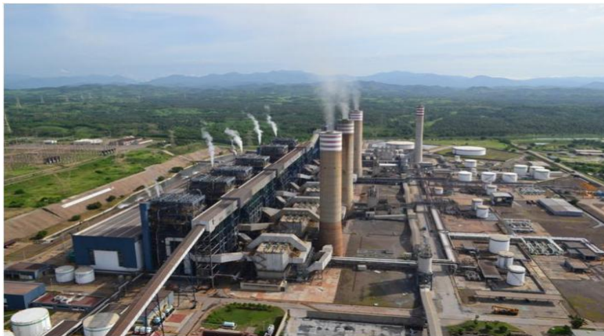
Imagen 1: Central Termoeléctrica Petacalco
