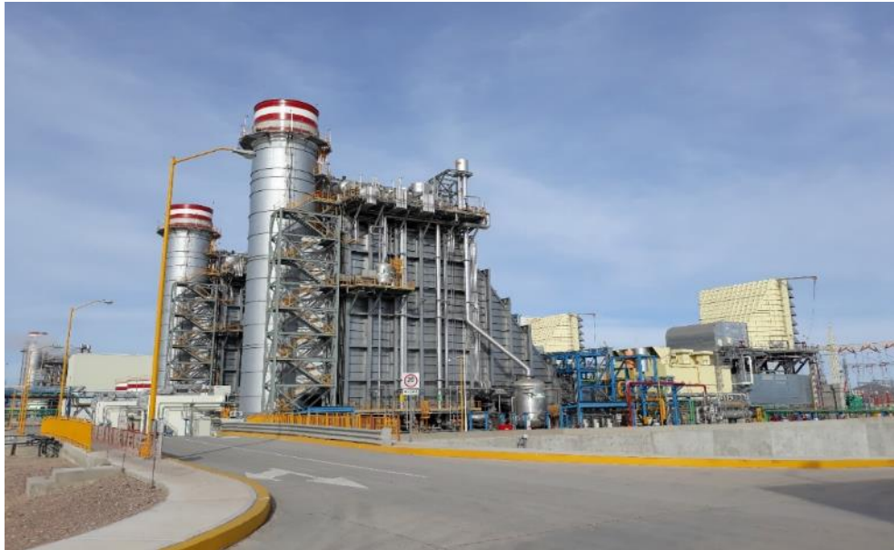
Fotografía: Panorámica CC Empalme I
