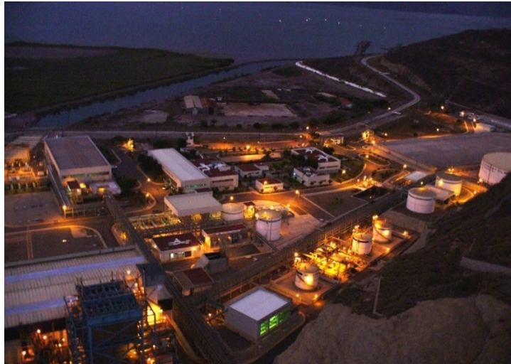
Imagen 3: Central Termoeléctrica Juan de Dios Bátiz Paredes
