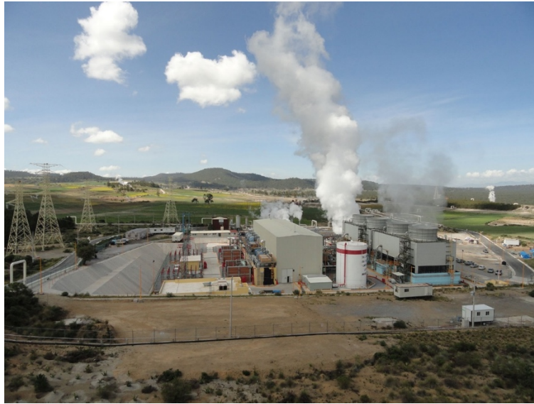
Imagen 1: Central Geotérmica Humeros
