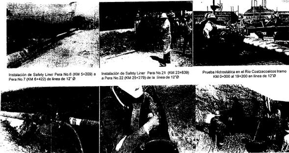
Instalación de Safety Liner Para No.6 (KM 5+209) a Para No.7 (KM 6+423) de línea de 12" Ø
