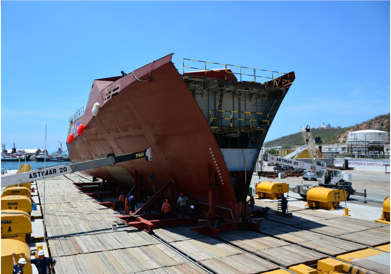
Construcción de una Patrulla Oceánica de Largo Alcance en ASTIMAR-20
