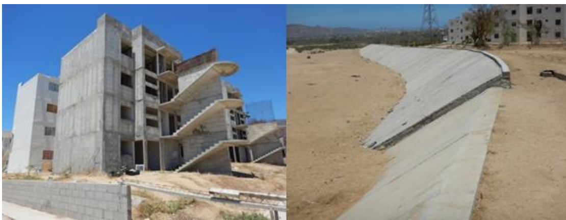
Foto. Opinión técnica sobre seguridad estructural de edificios e infraestructura de protección en Los Cabos, Baja California Sur. CENAPRED
