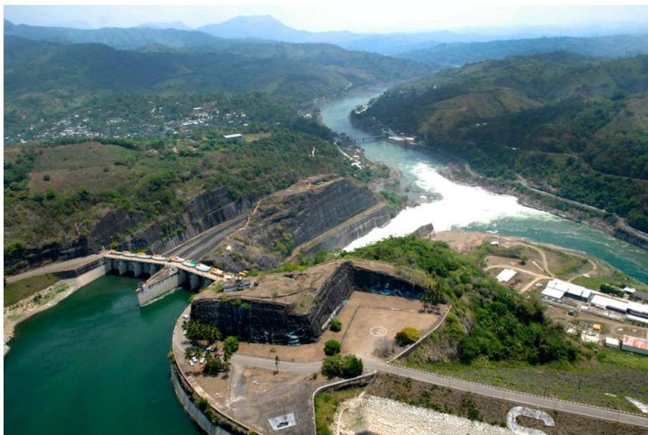
Central Hidroeléctrica Malpaso Capacidad 1,080.0 MW Volumen de generación 2018: 127.5 GW
