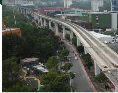
Viaducto elevado tramo III
