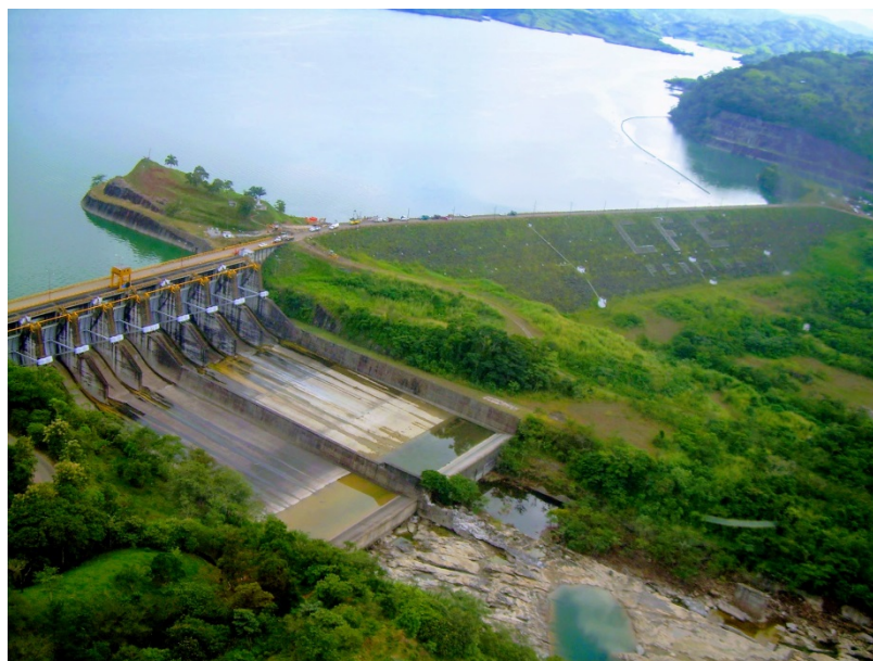
Central Hidroeléctrica Ángel Albino Corzo "Peñitas" Capacidad 420.0 MW Volumen de generación 2018: 78.8 GW
