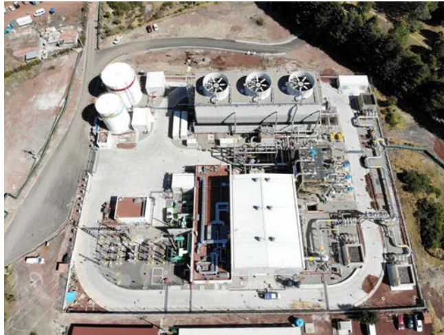
Central Geotermoeléctrica Azufres III Fase II
