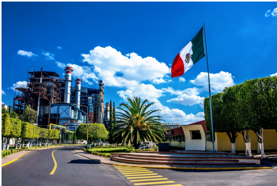
Central Termoeléctrica Salamanca Capacidad 550.0 MW Volumen de generación 2018: 134.3 GW
