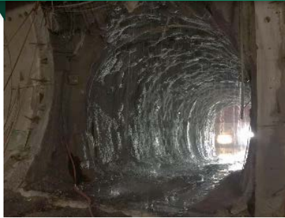
Excavación de galerías en túnel
