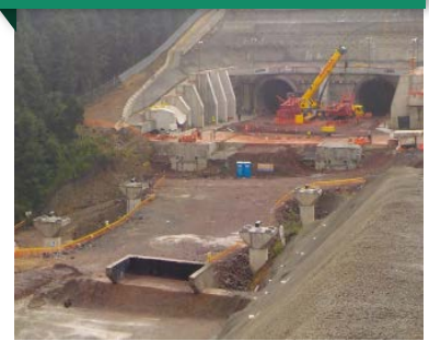
Portal poniente tramo II
