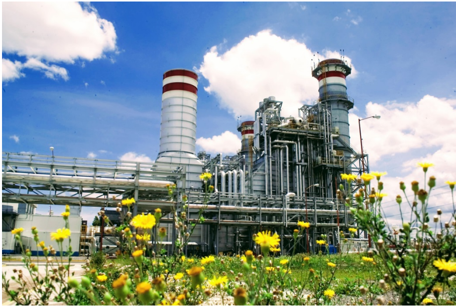
Central Ciclo Combinado El Sauz Capacidad 591.0 MW Volumen de generación 2018: 142.8 GW
