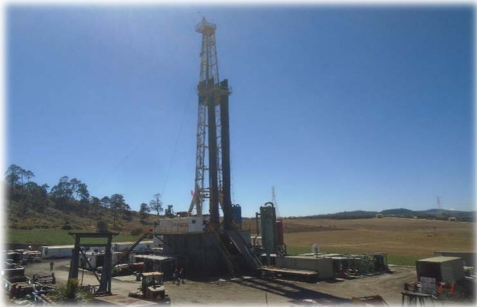
Perforación del Pozo H-52 en el Campo Geotérmico Los Humeros.
