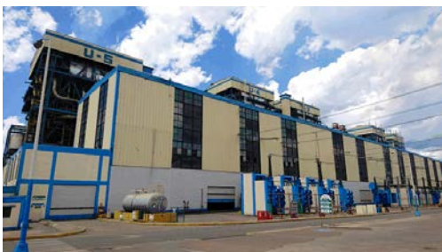
Sustitución de motoventiladores – Central Francisco Pérez Ríos. Potencial de ahorro: $21 millones de pesos anuales, Tula Hidalgo.
