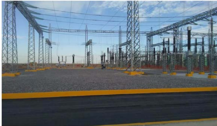
SE Terranova Ampliación / 283 LT Red de Transmisión Asociada al CC Norte III" Sitio Cereso
