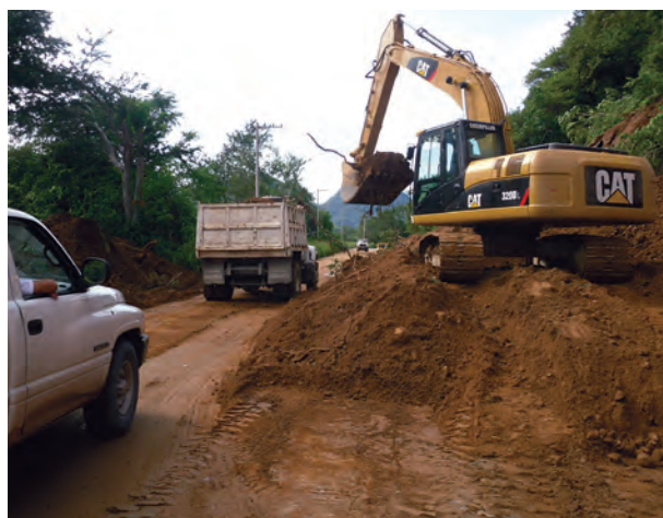
Reconstrucción de infraestructura.
