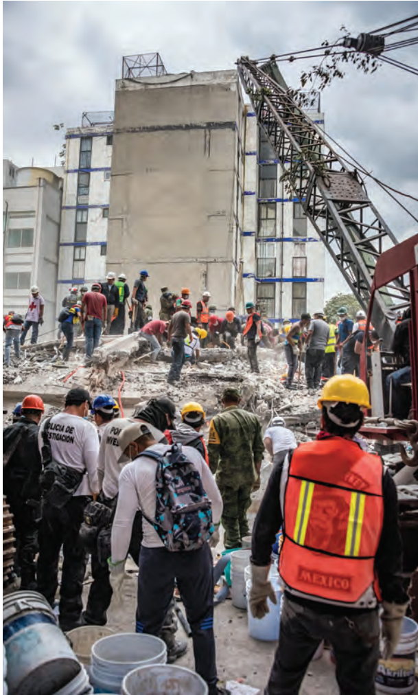
Atención de emergencias durante el sismo del 19 de septiembre de 2017, Ciudad de México.
