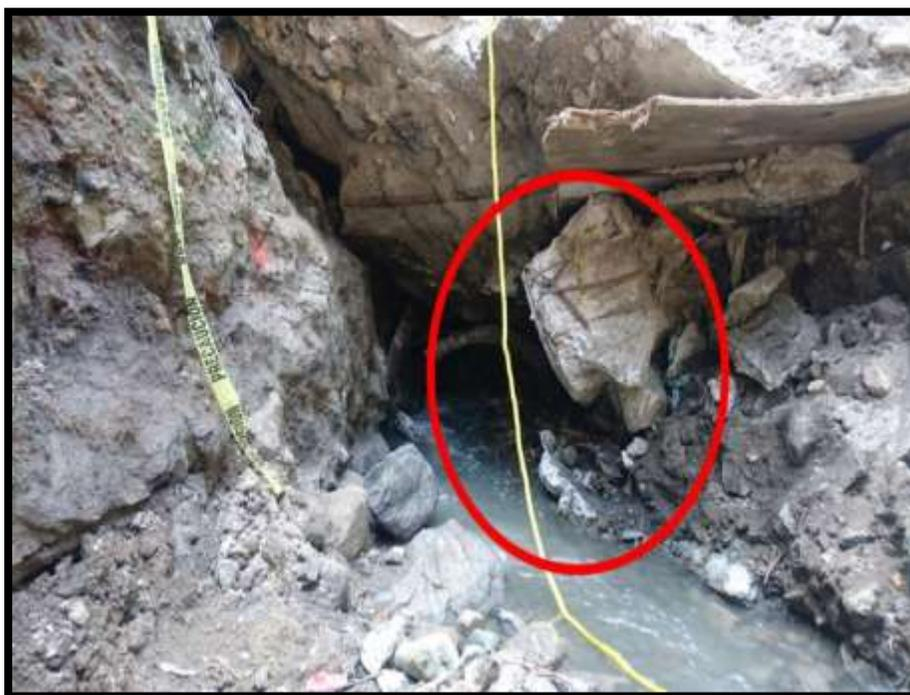
*En la circunferencia color rojo se representó el área original del tubo de concreto de la alcantarilla, la cual después de haber retirado parte de la basura y ramas, permite apreciar el aplastamiento del tubo y la base de concreto de la antigua cámara de video vigilancia.*
