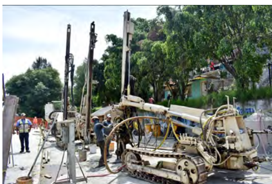
Imagen 17. Equipos de perforación para la ejecución del mejoramiento de suelos en la Carretera Xochimilco-Tulyehualco. Fuente: twitter @SOBSECDMX
