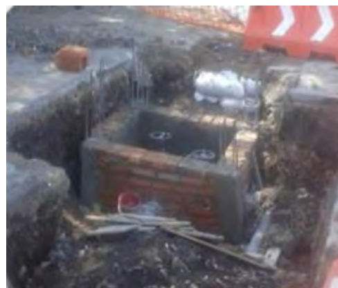
Imagen 30. Construcción de cajas operadoras de válvulas. Fuente: Informe de la Delegación Tláhuac.
