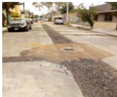
Imagen 29. Conclusión de trabajos obras de drenaje. Fuente: Informe de la Delegación Tláhuac.
