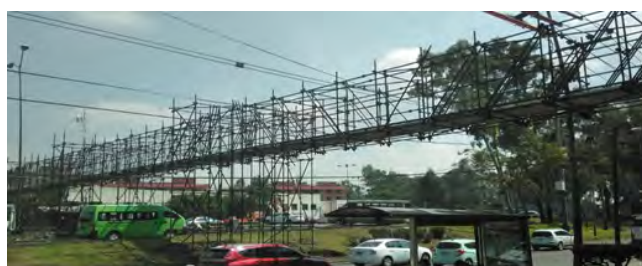
Imagen 34. Puente provisional 2 Anillo Periférico y Av. Canal Nacional
