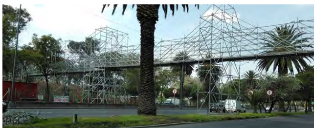
Imagen 33. Puente provisional 1 Anillo Periférico y calle Cañaverales
