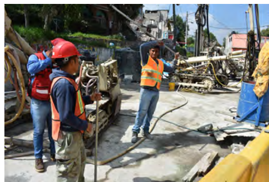
Imagen 18. Trabajadores en la realización de actividades para el mejoramiento de suelos en la Carretera Xochimilco-Tulyehualco. Fuente: twitter @SOBSECDMX
