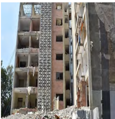
Imagen 12. Actividades de demolición, clareo de losas.
