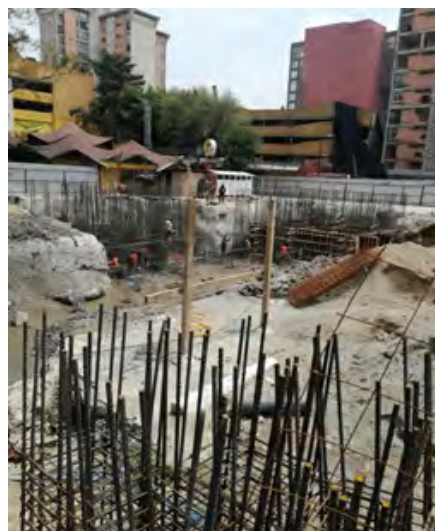
Imagen 14. Trabajos de reconstrucción del inmueble
