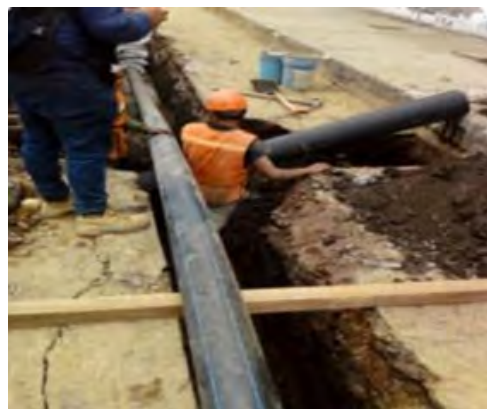
Imagen 31 Sustitución de tubería de la red de agua potable para tomas domiciliarias. Fuente: Informe de la Delegación Tláhuac.
