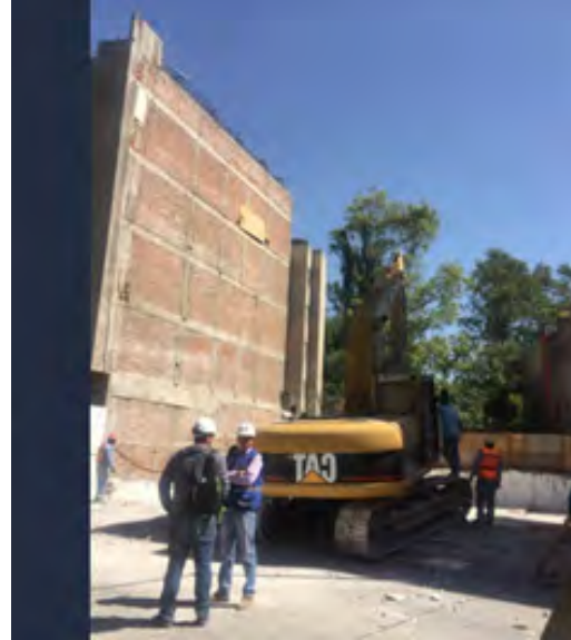
Imagen 23. Limpieza y disposición del lote limpio.
