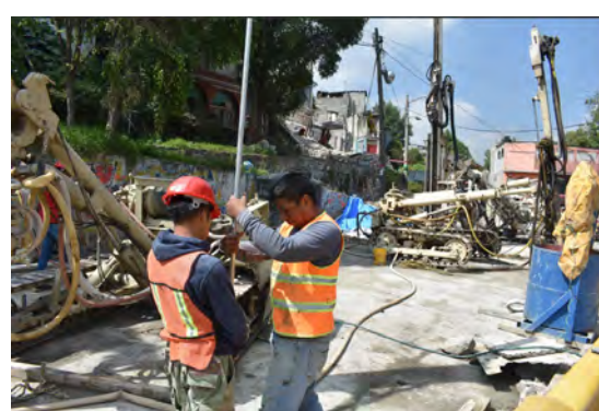
Imagen 19. Trabajadores en la realización de actividades para el mejoramiento de suelos en la Carretera Xochimilco-Tulyehualco. Fuente: twitter @SOBSECDMX
