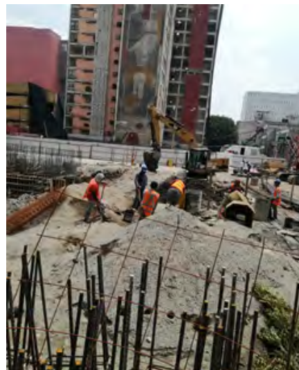
Imagen 13. Trabajos de reconstrucción del inmueble
