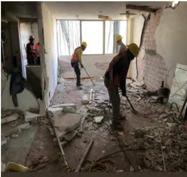
Imagen 22. Trabajos de demolición manual.
