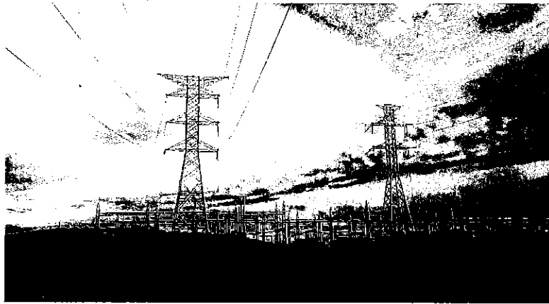
L.T. Santa Ana – Nogales Aeropuerto / SLT 2001 SE y LT Baja California Sur - Noroeste (1a Fase)
