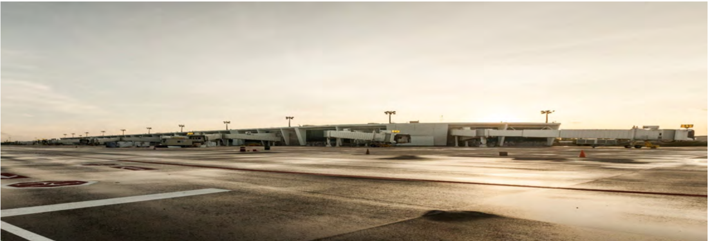
Ampliación de la Terminal 4, Aeropuerto de Cancún, Quintana Roo, con capacidad para atender a 8 millones de pasajeros al año.
