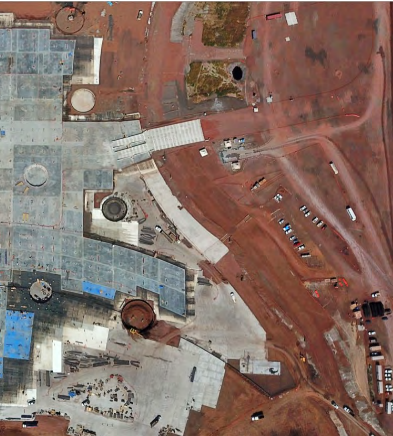
Avance de loza de cimentación del Edificio Terminal, NAIM.
