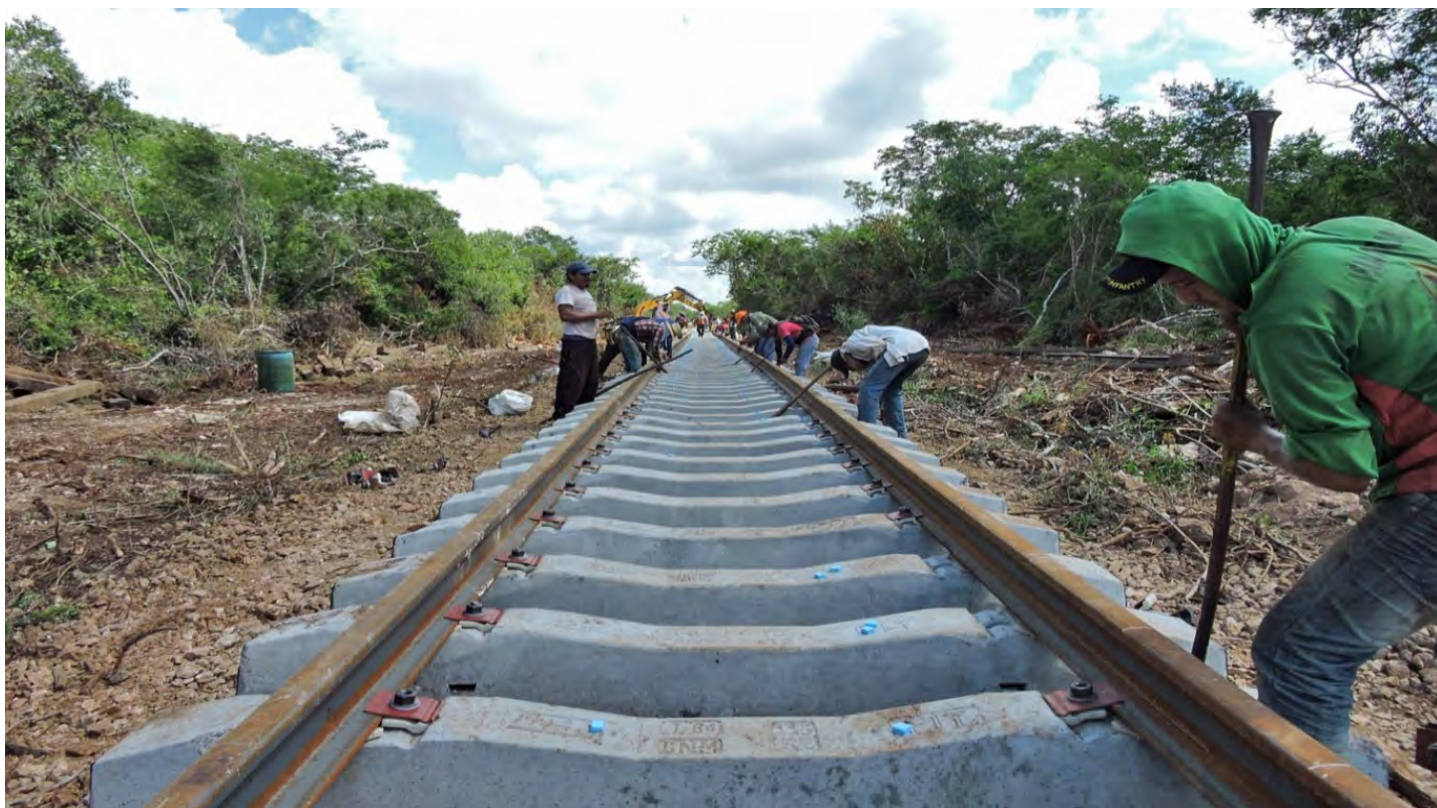
Rehabilitación de las vías del Tren Chiapas–Mayab.
