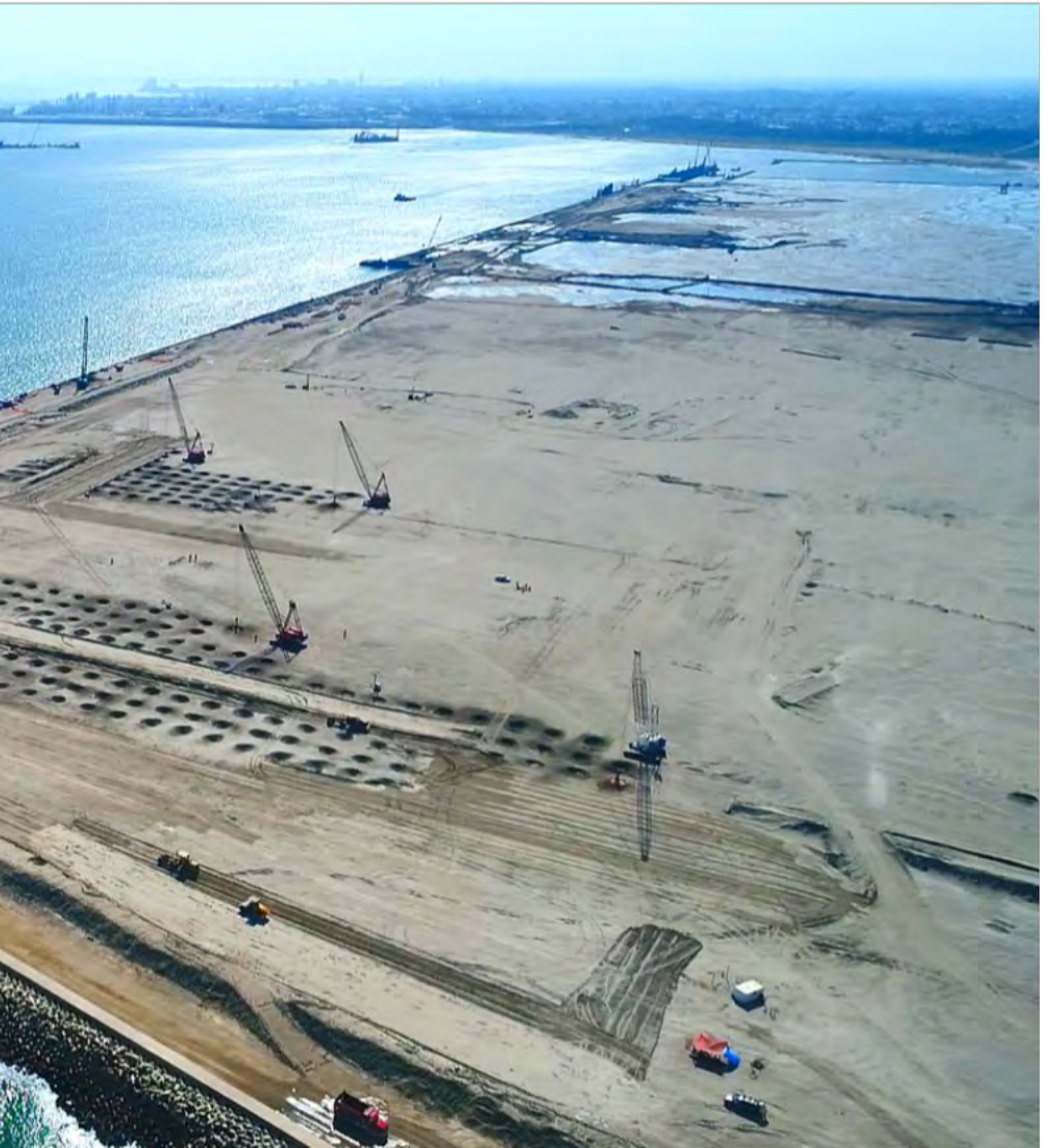
Nuevo Puerto de Veracruz. Durante el segundo semestre del año 2017 se concluyó la escollera, se avanzó en el dragado del canal de navegación y en el relleno de los muelles con lo que se alcanzó el 70% de avance general.
