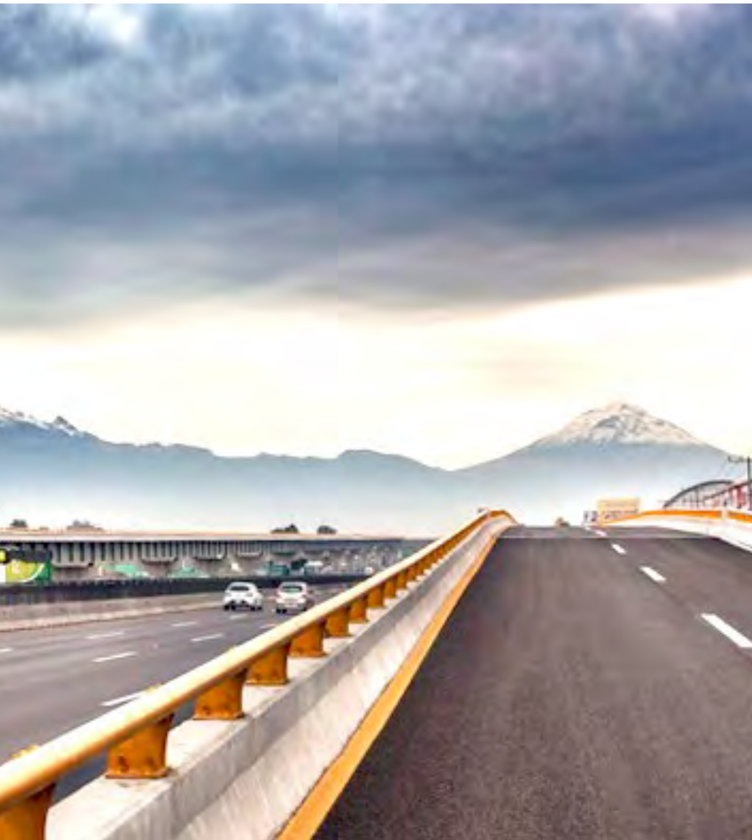
Ampliación de la autopista México-Puebla.
