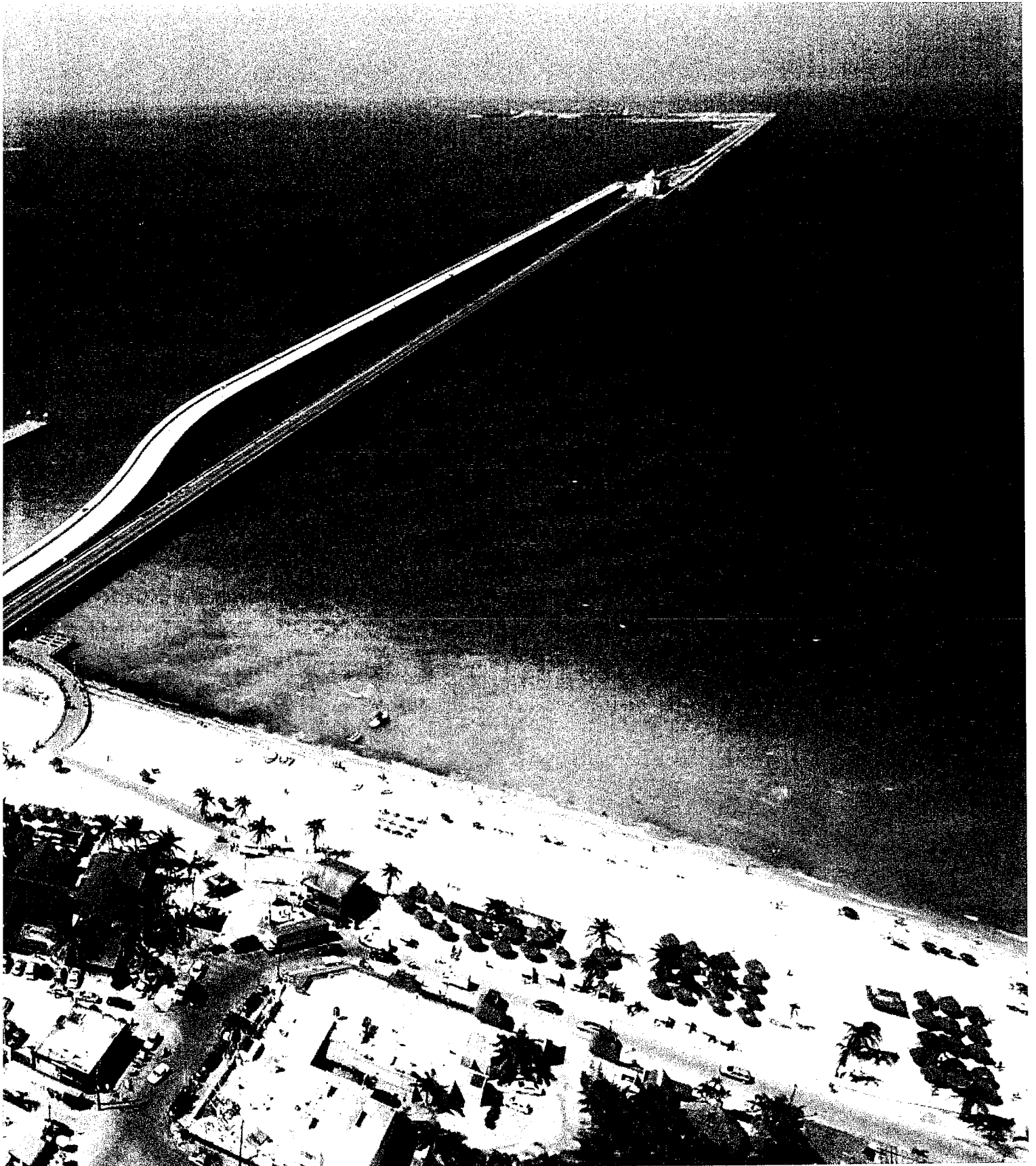
Viaducto Alterno al Puerto de Progreso
