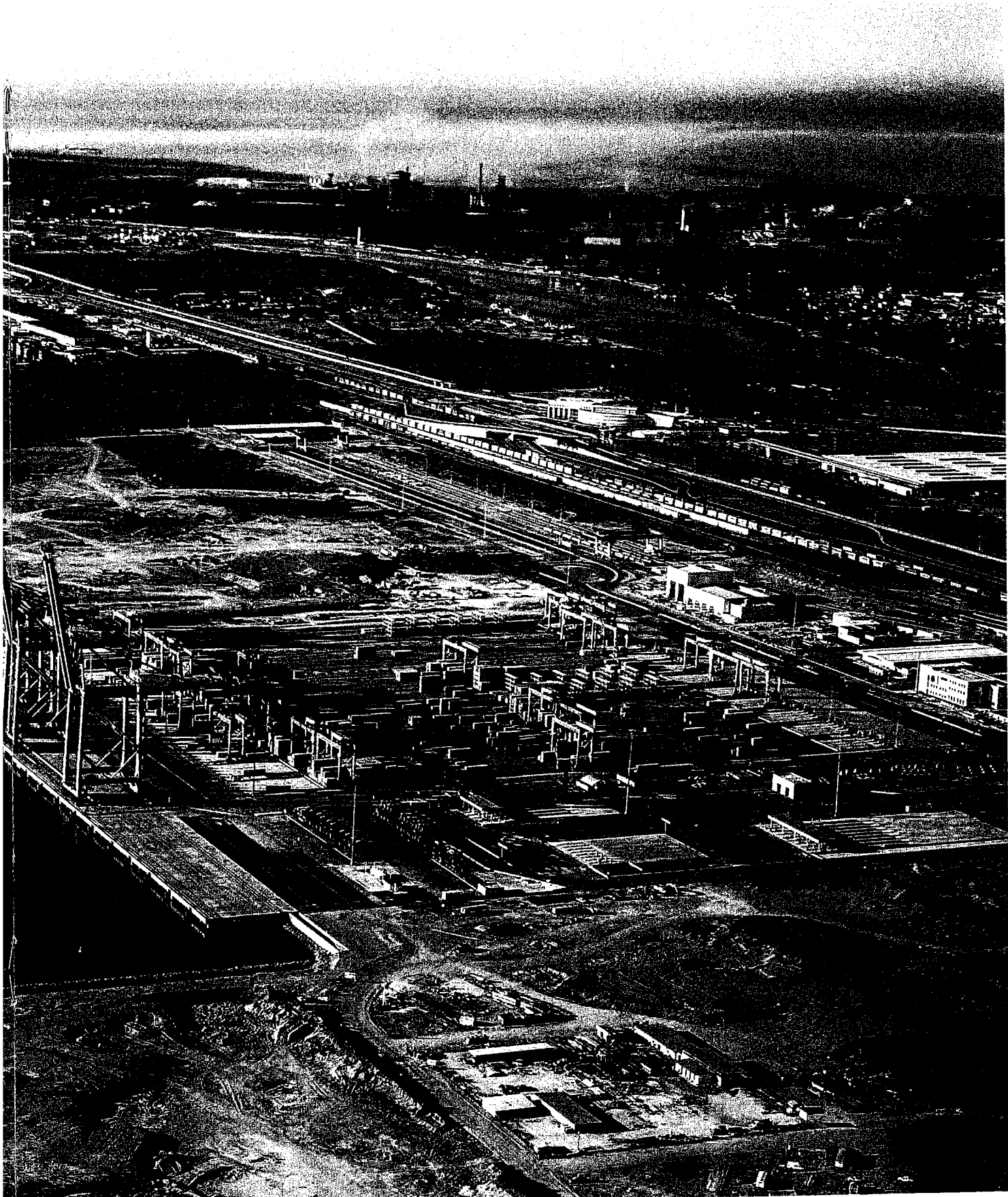
Terminal Especializada de Contenedores II (TEC II) Puerto de Lázaro Cárdenas
