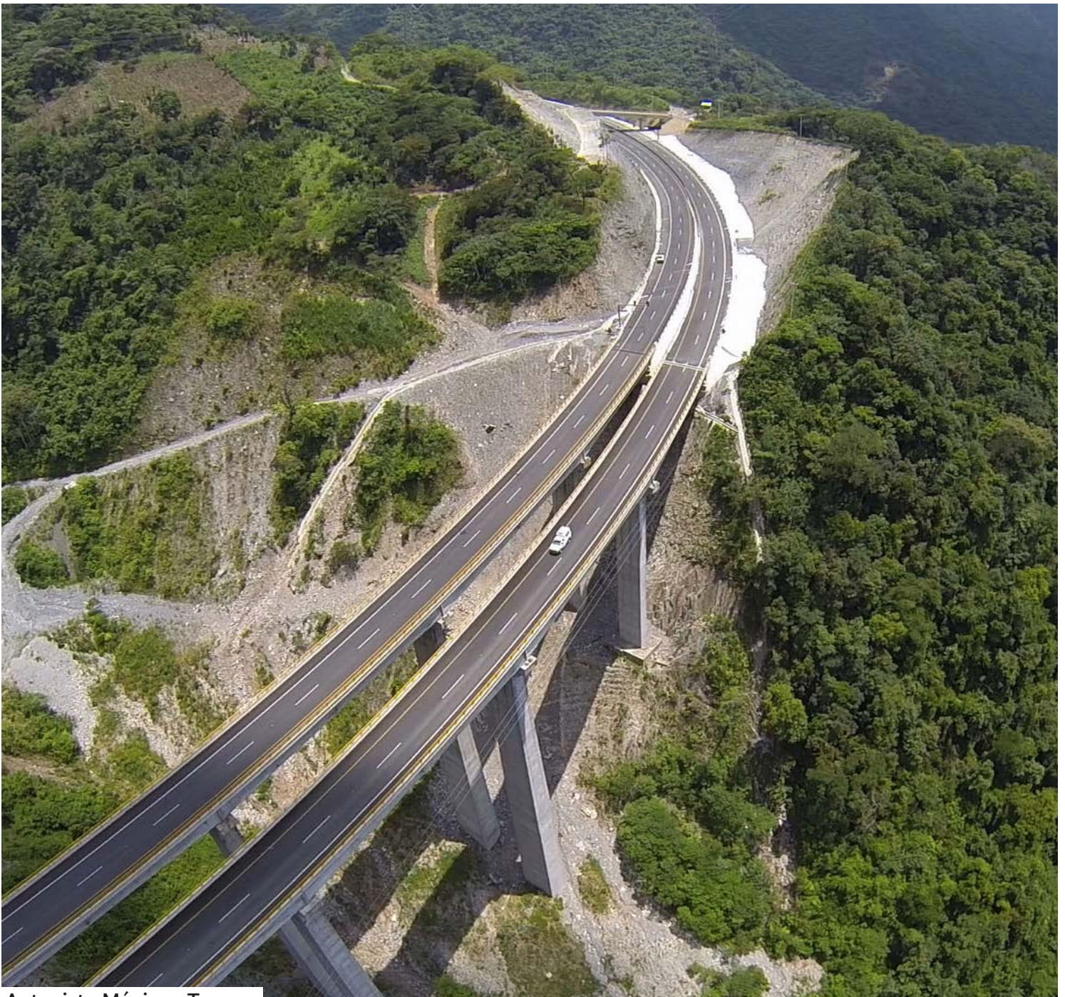
Autopista México - Tuxpan
