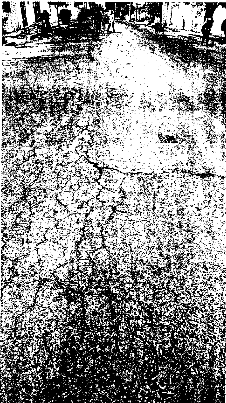
Fotografía 10. Grietas en bloque sobre la calle Laguna de Ensueño, se pueden apreciar los recientes trabajos del drenaje.
