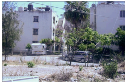
Antes de la intervención
