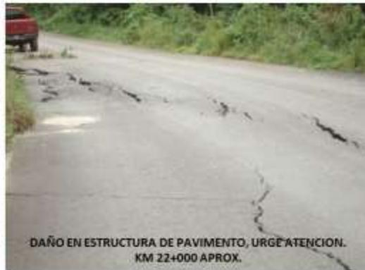
DAÑO EN ESTRUCTURA DE PAVIMENTO, URGE ATENCION. KM 22+000 APROX.
