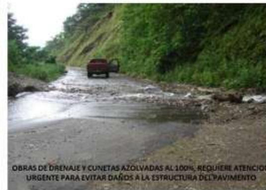
OBRAS DE DRENAJE Y CUNETAS AZOLVADAS AL 100%. REQUIERE ATENCION URGENTE PARA EVITAR DAÑOS A LA ESTRUCTURA DEL PAVIMENTO
