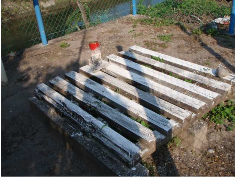
Base del tanque de evaporación
