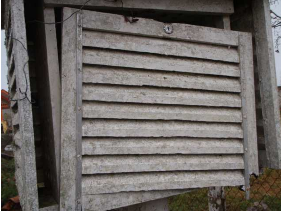
Acercamiento al abrigo meteorológico
