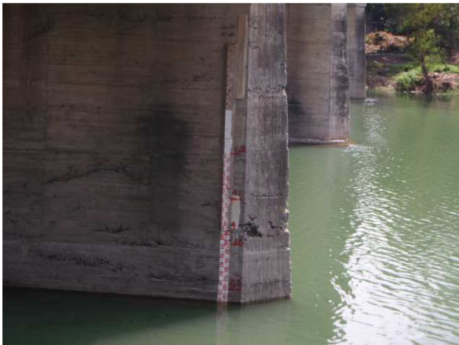
Vista de la escala hidrométrica
