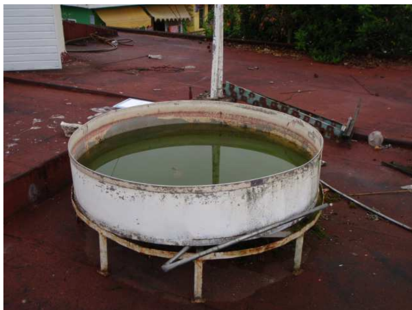
Tanque de evaporación
