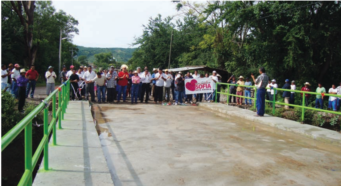
Puente Nuchita terminado.
