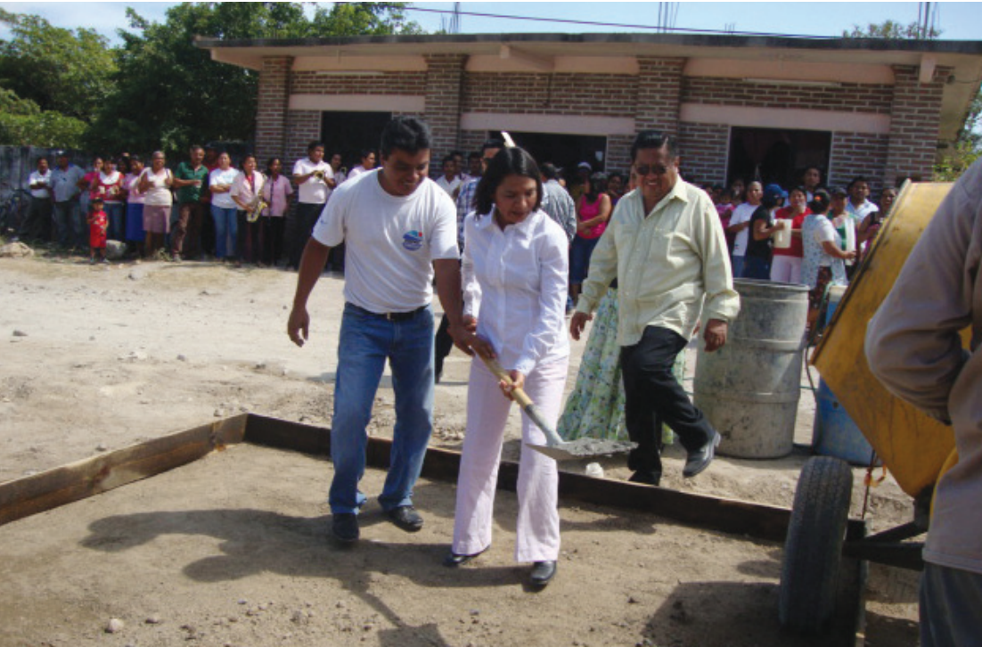
Inicio de obras de pavimentación en el Municipio de San Pedro Mixtequilla, recursos del FOPADEP 2011.
