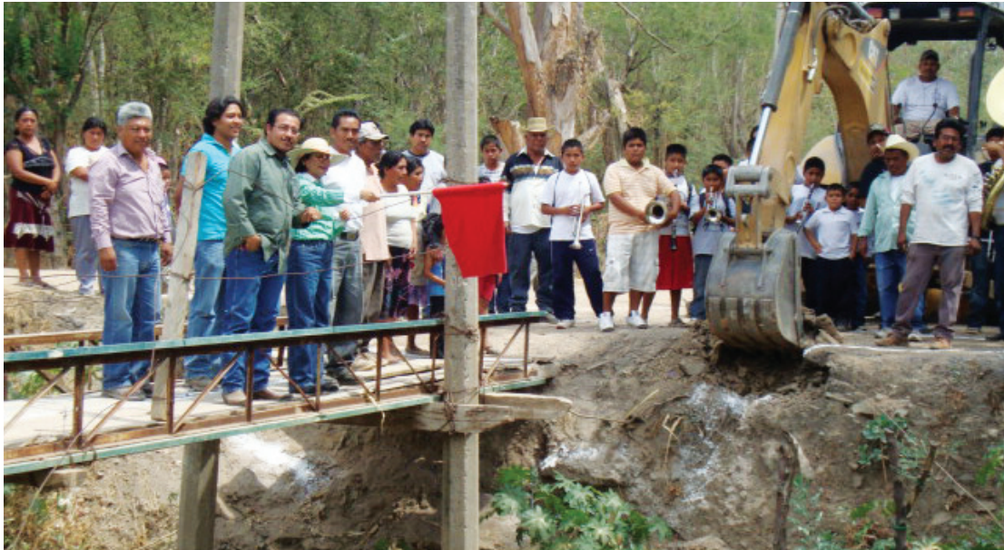
Banderazo de obra de la construcción del puente y de la “Ampliación de Sistema de Agua Potable” en San Jorge Nuchita (esta última con recursos del CDI, inversión de $2’488,000.00).
