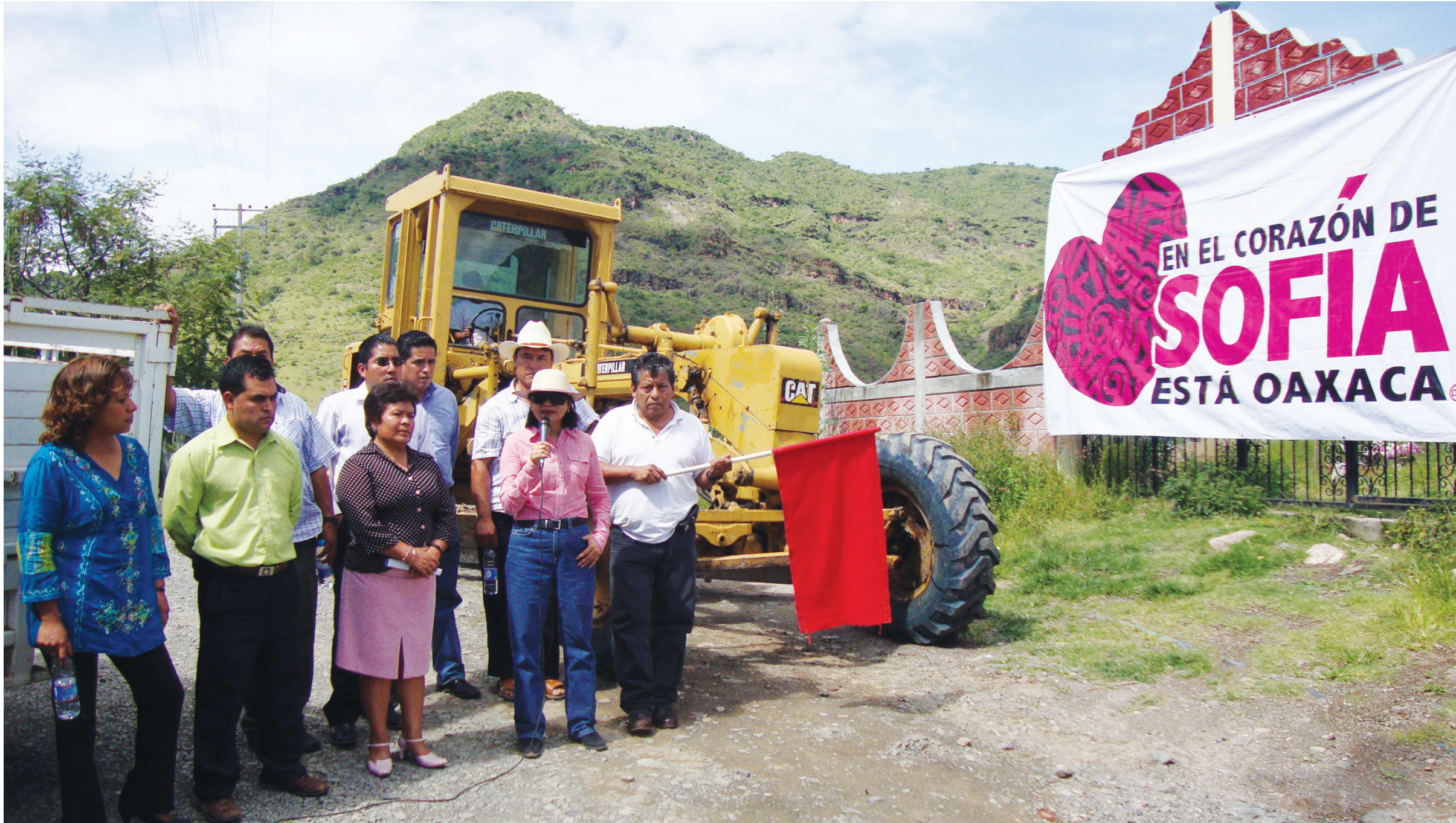
Iniciando nivelación y pavimentación de calles en Asunción Cuyotepeji.
