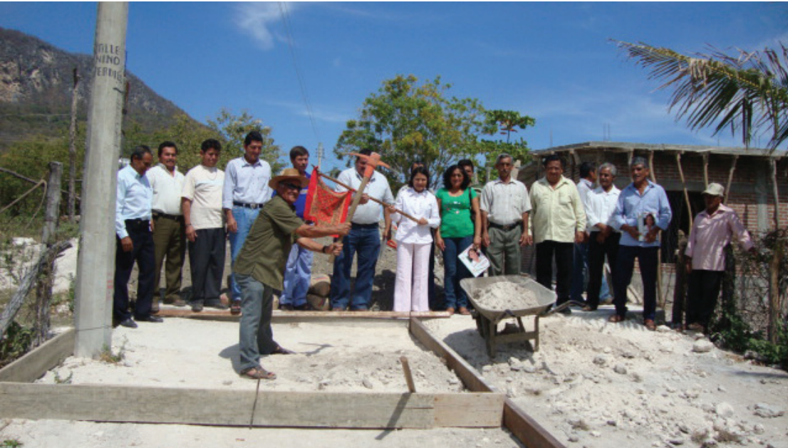
Inicio de obras en el Municipio de Magdalena Tlacotepec
